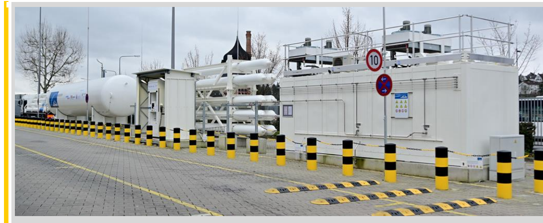
Abbildung 2.20: Typische Elemente einer Wasserstofftankstelle [Volker Watschounek]
