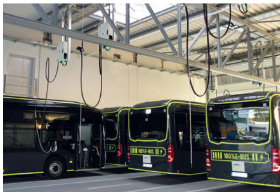
5-14 | Abbildungen zum beispielhaften Flächenbedarf (links: Reutlinger Stadtverkehrsgesellschaft, Ladegerüst) (rechts: Kölner Verkehrsbetriebe, Ladesäule KVB)
