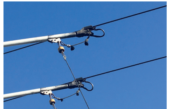
5-6 | Oberleitungsbus von Solaris in Solingen (oben), Stromabnehmer eines Obus (unten)
