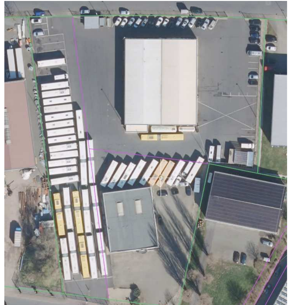
Abbildung: Vollgestellter Betriebshof
