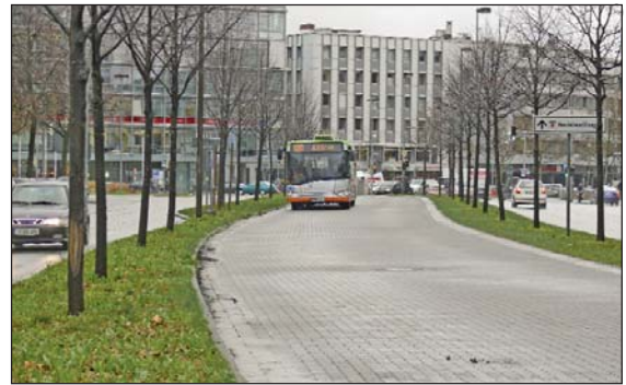
Auch in Deutschland möglich: Bus „auf besonderem Bahnkörper“ zwischen den Richtungsfahrbahnen. (Foto: Bernhard E. Nickel)
