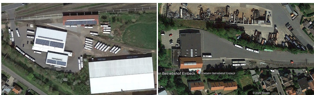
Abbildung 2-9 Beispiele für Betriebshöfe mit geringen Flächenreserven
