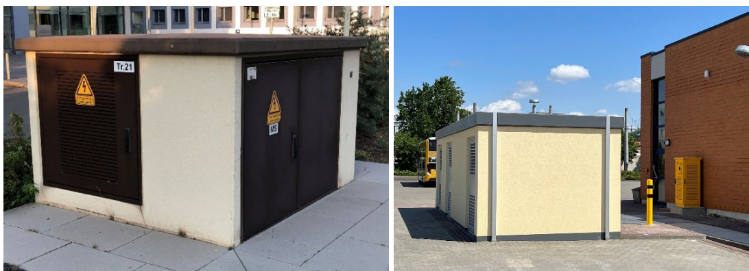
Abbildung 2-3 Beispiele für einen Kompakttransformator und eine begehbare Transformatorenstation
