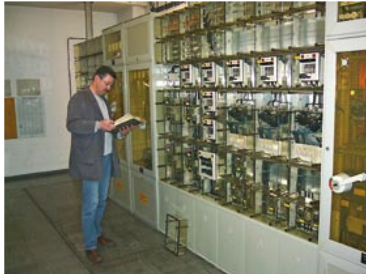
Inspektion einer 400-Volt-Anlage einer weiteren unterirdischen Haltestelle in Frankfurt am Main
