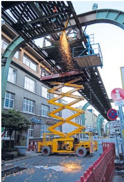
Erneuerung des Gerüsts der Wuppertaler Schwebebahn
